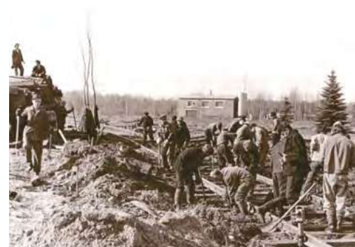
Прокладка ж.д. пути к СВС
