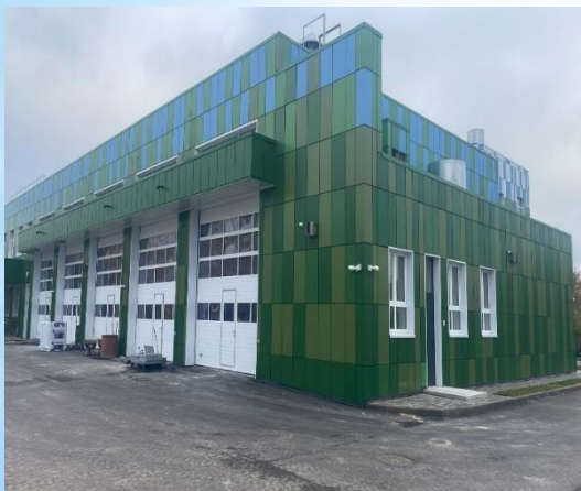
Пожарное депо по адресу: Дмитровское шоссе, вл.163. Планируемое окончание работ и ввод в эксплуатацию – 1 квартал 2024 г.
