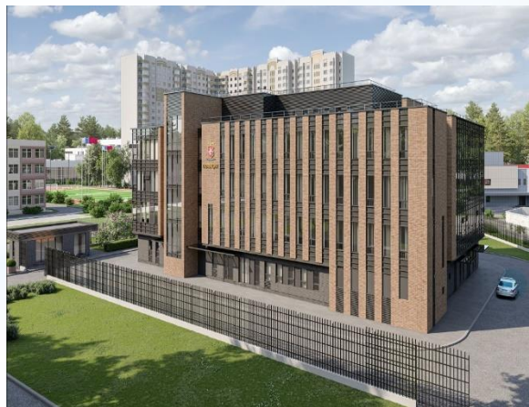
Здание МВД по адресу: 9-я Северная линия, вл.25, корп.2. Планируемое окончание работ и ввод в эксплуатацию – 4 квартал 2024 г.
